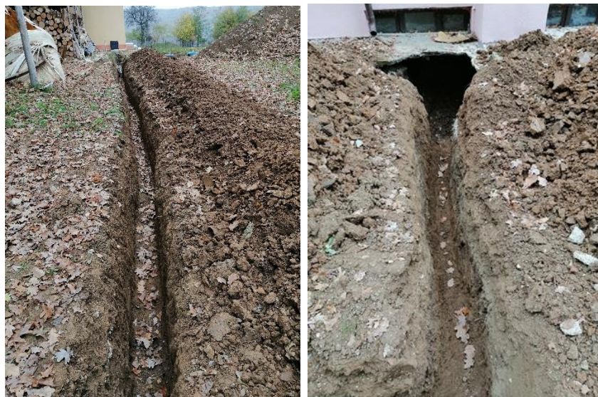
Figura 3 Lucrări de înlocuire a sistemului exterior de alimentare cu apă a stațiunii
