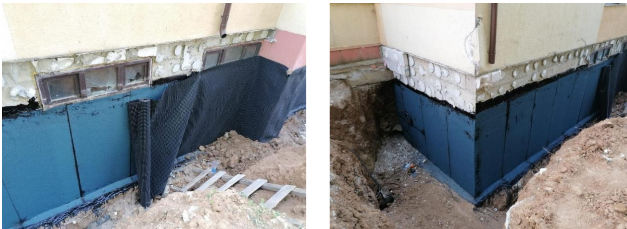
Figura 1. Lucrări de realizare a hidroizolației fundației clădirii principale a stațiunii
