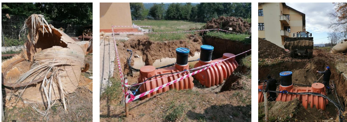
Figura 2. Lucrări de înlocuire a rezervoarelor de apă din cadrul stațiunii
